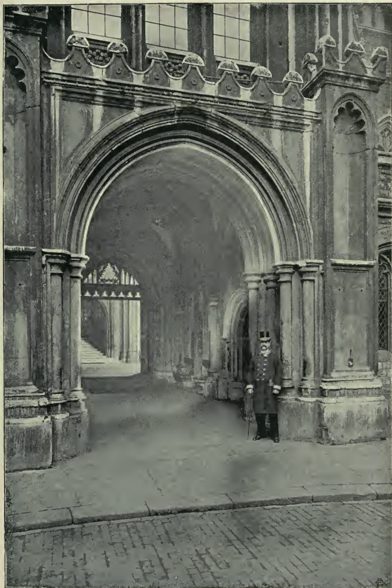
Photo by the L. S. & P. Co., Ltd.
